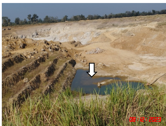
รูปที่ 15 บ่อรองรับน้ำ (Sump)
